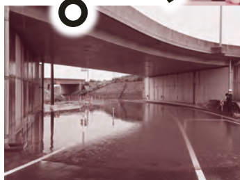
いつもとは違う所も冠水(中区中島)
