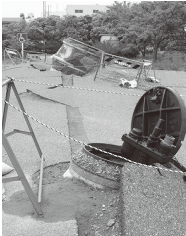
▲千葉県浦安市の液状化被害
