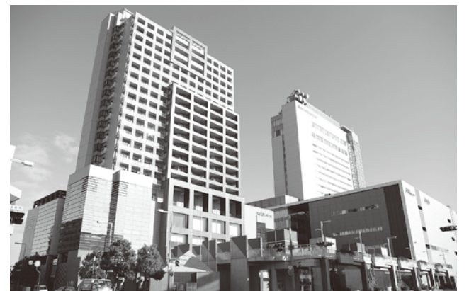
▲既存施設との関係も未整理です
