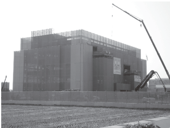
▲南区役所建設中
