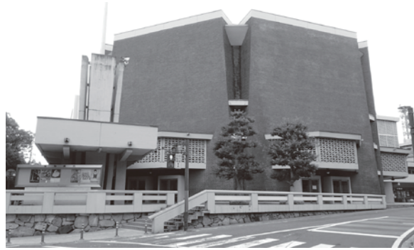
▲建て替えが必要な市民会館
