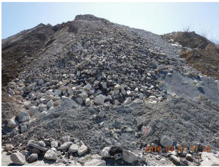
熊谷川の土砂崩落の様子
