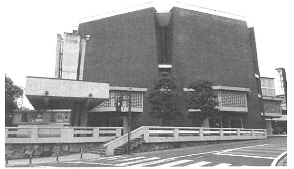
▲建て替えが必要な市民会館
